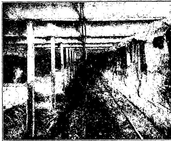
Фиг. 1. Желѣзно-крѣпленіе подземной конюшни.
